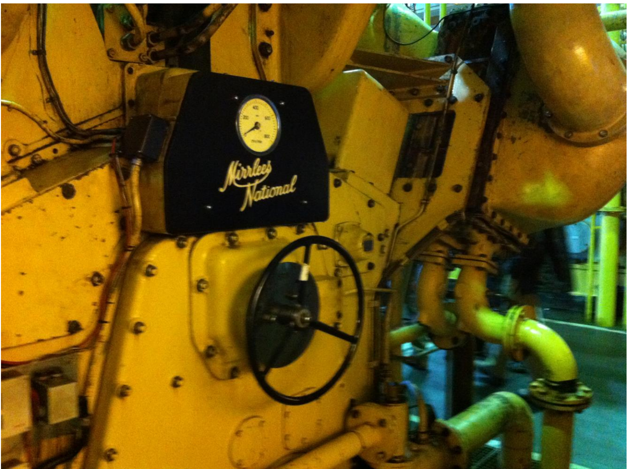
En af fire dieselmotorer i Dieselværket
