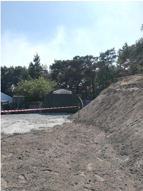
Nedlæggelse af Fyrvej og stien, afgravning af terræn. Tilførsel af materiale.
